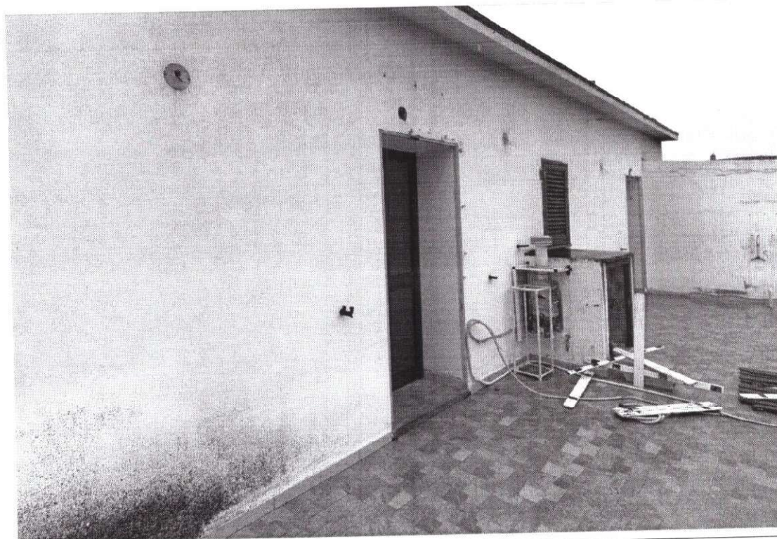
Foto 20, piano primo – vista esterna terrazza con in evidenza porzione immobile in abuso
