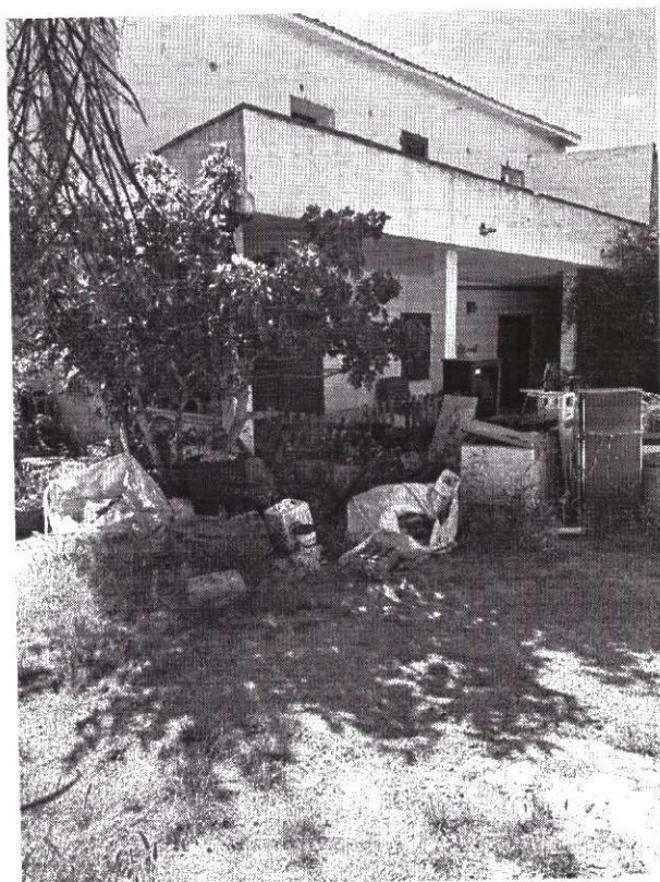
Foto 3 - vista esterna immobile dal subalterno (BCNC)
