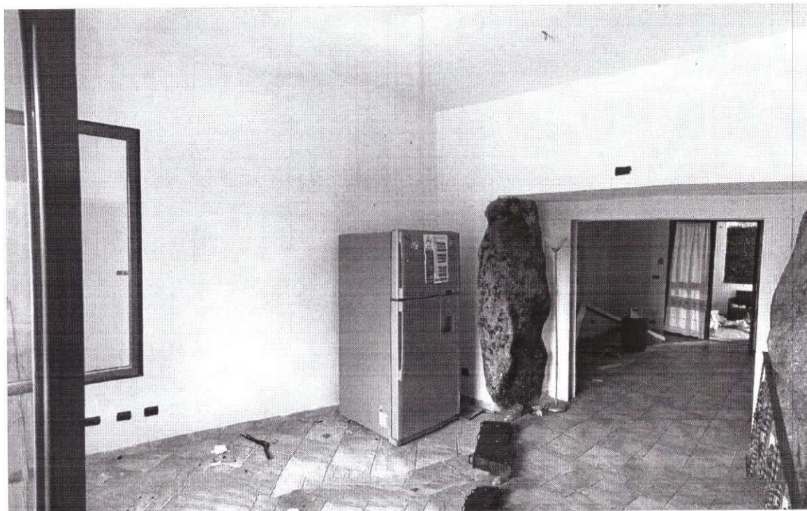
— Foto 7, piano terra – vista interna vano pranzo/soggiorno
