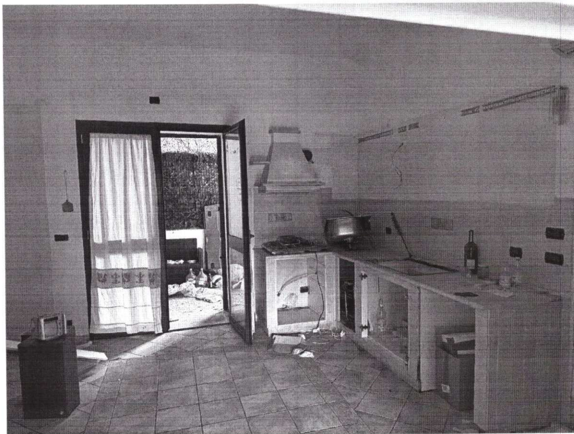
— Foto 8, piano terra – vista interna cucina
